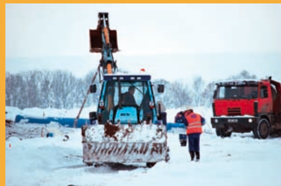
Přeložka vody a kanalizace, Droužkovice – Vysočany
