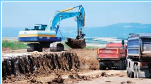
Odkop zeminy v zářezu.
