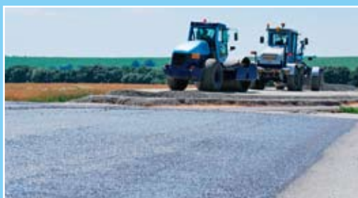
Povrch připravený k položení nejméně vrstvy asfaltové komunikace, po které budeme jezdit.
